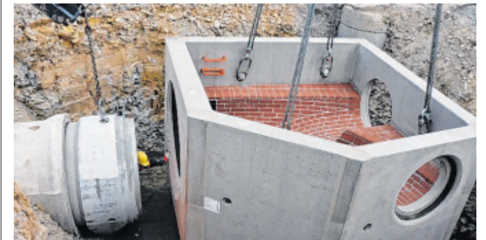
Zentral: Über dieses kürzlich eingelassene Becken wird das gesamte Regenwasser aus dem Baugebiet abgeführt. FOTO: STADT PB / LEA GIESEN
